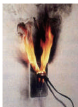
トラッキング現象
